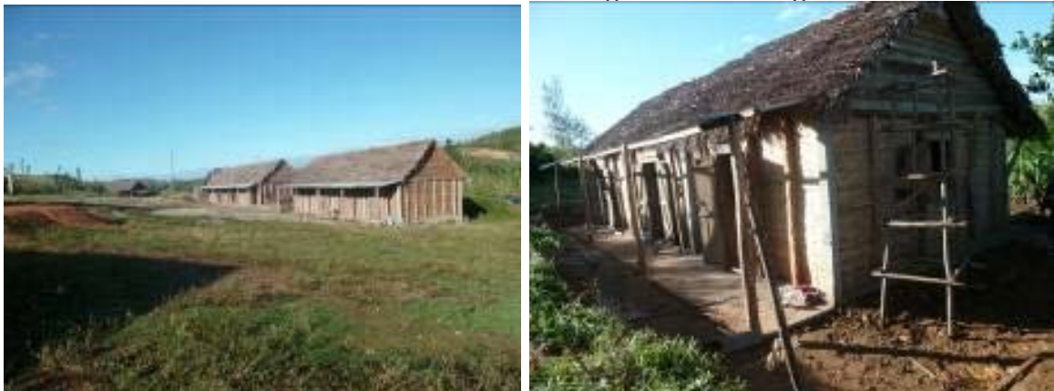
Les 2 bâtiments école et les 3 logements enseignants
