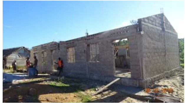
Le nouveau bâtiment en construction
