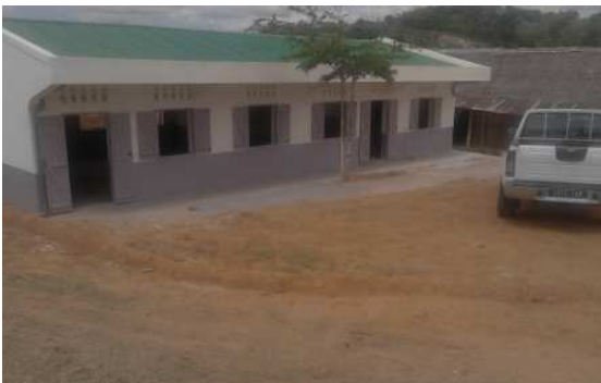
Le nouveau bâtiment livré pour la rentrée 2017 (1ere tranche)
