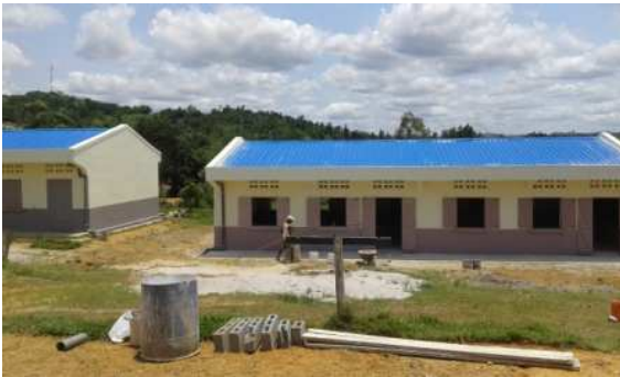
Le dernier bâtiment fin prêt pour la rentrée
